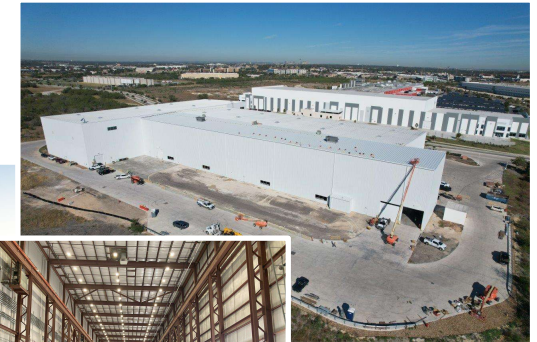
▲増床工事の様子
