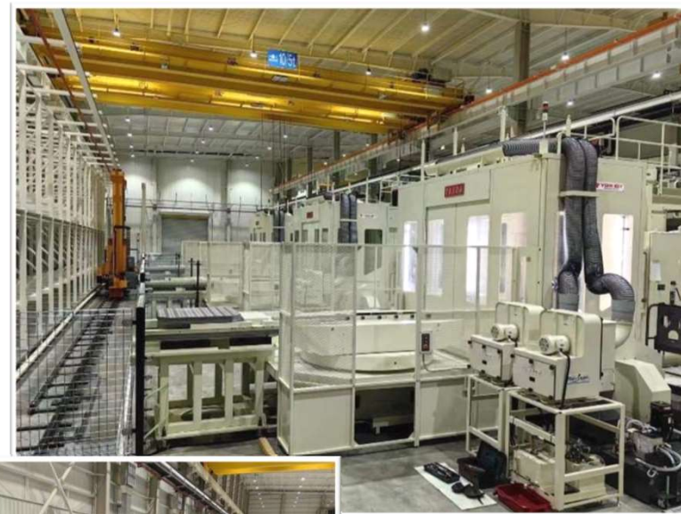
▲第1期導入設備 (マシニングセンター・自動搬送装置)
